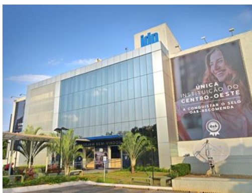
Figura 1 - Fachada da sede do IDP Brasília
